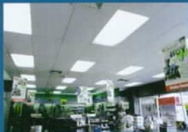
Los plafones son placas decorativas moldeadas y cortadas, utilizadas para ser suspendidas en los cielos de azoteas, cubiertas de entre piso y permitir el ocultamiento de instalaciones eléctricas, hidráulicas, de refrigeración o calefacción, contribuyen al amortiguamiento de ruidos y vibraciones, proporcionando además un aspecto estético y soporte
