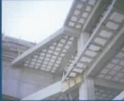
Las bovedillas de Aislantes y Empaques se fabrican de Poliestireno Expandido en las dimensiones adecuadas para trabajar en los sistemas constructivos de vigueta pretensada o semivigueta, utilizados en losas de azotea y entrepiso proporcionandoles ligereza y gran resistencia estructural a bajo coste.
